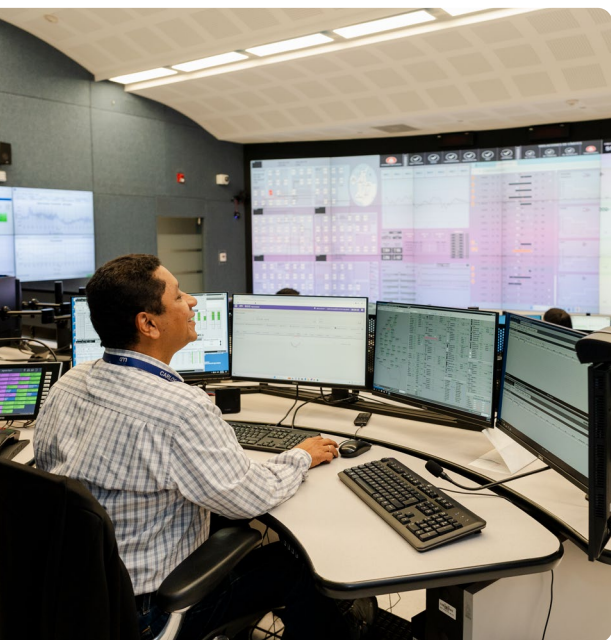
Centro de Control del Centro Nacional de Despacho XM, 2025. Fotografía: XM.
