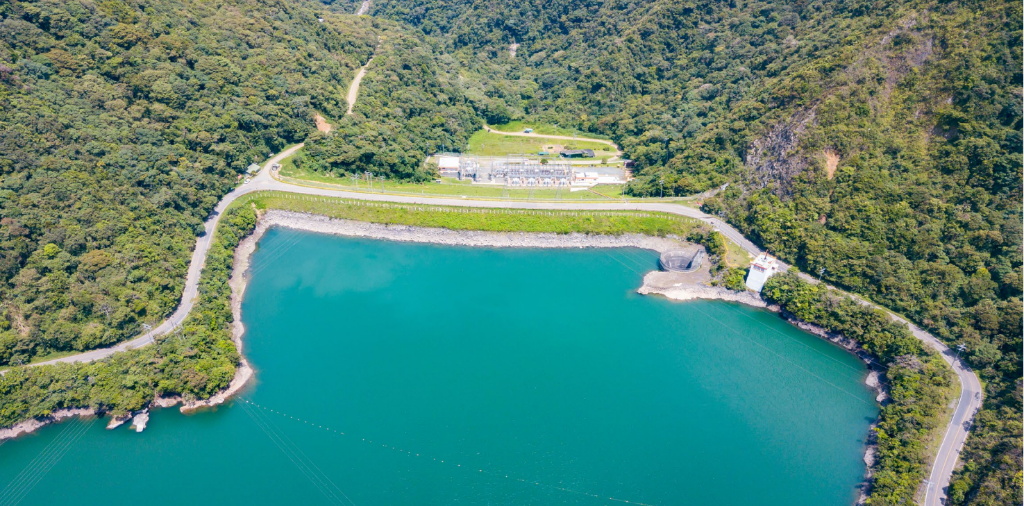
Central hidroeléctrica Calima, Valle del Cauca, 2022. Fotografía: Celsia.
