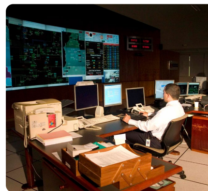
Centro de Control del Centro Nacional de Despacho XM, 2007. Fotografía: XM.
