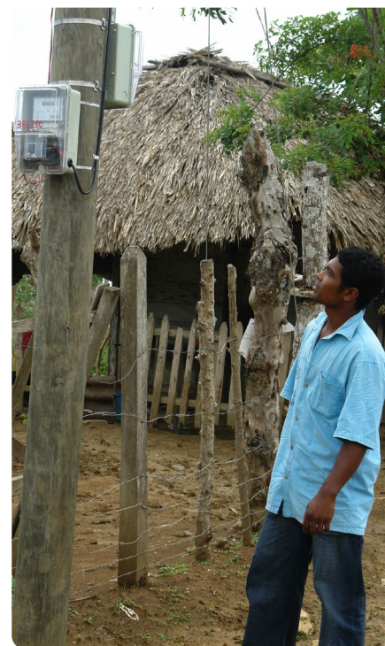
Electrificación rural, Arboletes, 2009. Fotografía: EPM.
